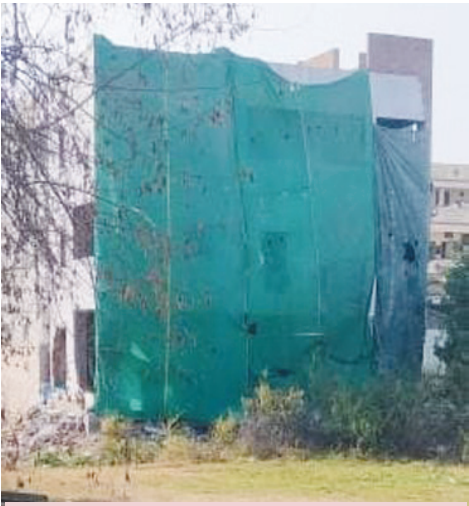
కూల్చివేసిన బీఆర్ఎస్ నేత అక్రమ నిర్మాణంలో పరదాల చాటున పనులు..
