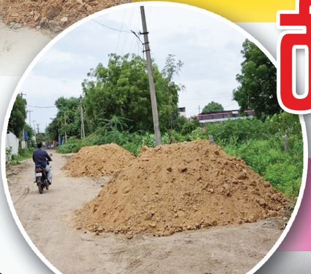
227 ప్రభుత్వ భూమిలో రోడ్డు నిర్మాణంలో చదును చేయడానికి సిద్ధంగా ఉన్న మట్టి కుప్పలు..
