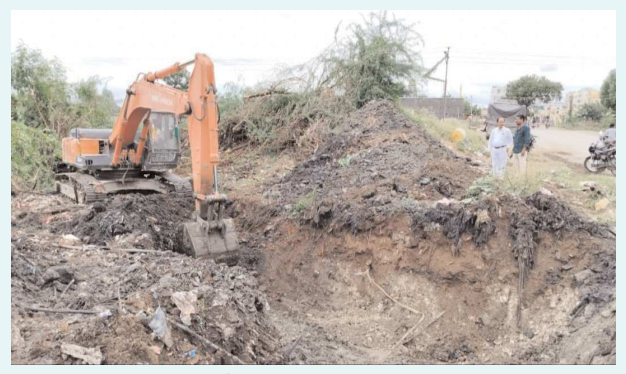
కనిగిరి ఆర్బీఐఓవార్డ్, పెన్ పవర్ ఆగస్టు 7 కనిగిరి మున్సిపాలిటీలో డ్రైనేజీ కాలువల్లో పూడికతీత పనులకు రాష్ట్ర ప్రభుత్వం రూ. 33 లక్షల నిధులను మంజూరు చేసింది కనిగిరి మున్సిపల్ చైర్మన్ అబ్దుల్ గఫార్ అన్నారు. బుధవారం పట్టణంలోని శ్రీఅభయంజనేయ స్వామి ఆలయం సమీపంలో వాగు చెప్పా వద్ద కాలువలో పూడిక తీత పనులను మున్సిపల్ చైర్మన్ అబ్దుల్ గఫార్ బుధవారం పరిశీలించారు. ఈ సందర్భంగా మున్సిపల్ చైర్మన్ షేక్ అబ్దుల్ గఫార్ మాట్లాడుతూ దశాబ్దాలగా కాలువల్లో పేరుకుపోయిన పూడును తీసి నీరు సాఫీగా వెళ్లాలి చర్యలు తీసుకుంటున్నట్లు తెలిపారు. మున్సిపాలిటీ పరిధిలోని కాలువల్లో ఈ పనులు చేపట్టి ఎక్కడ డ్రైనేజీ నీరు కానీ, వర్షపు నీరు కానీ నిలవకుండా చర్యలు తీసుకుంటామన్నారు. కార్యక్రమంలో మున్సిపల్ ఏక కోటేశ్వరరావు, మున్సిపల్ సిబ్బంది తదితరులు పాల్గొన్నారు.
